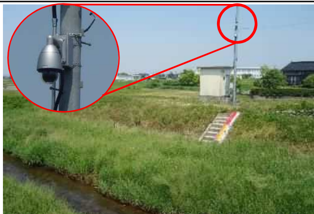
河川監視カメラ設置状況
