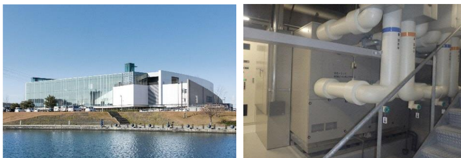
図 6-5 富山県美術館に導入された地中熱（地下水熱）ヒートポンプによる冷暖房システム
