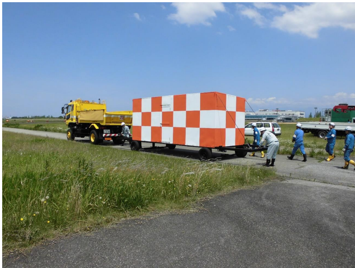
計器着陸装置(ローライザー)を撤去
