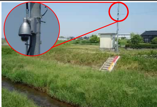
河川監視カメラ設置状況
