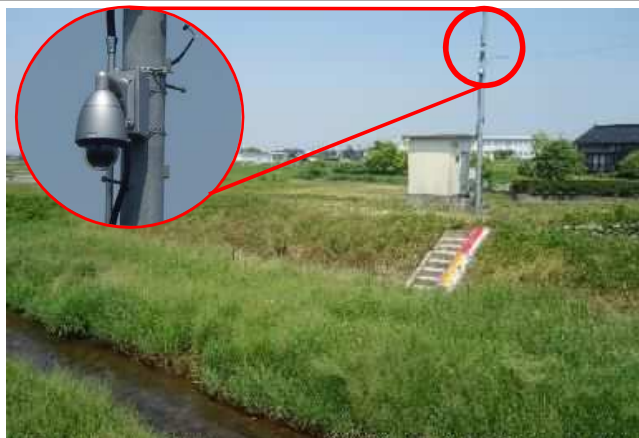
河川監視カメラ設置状況
