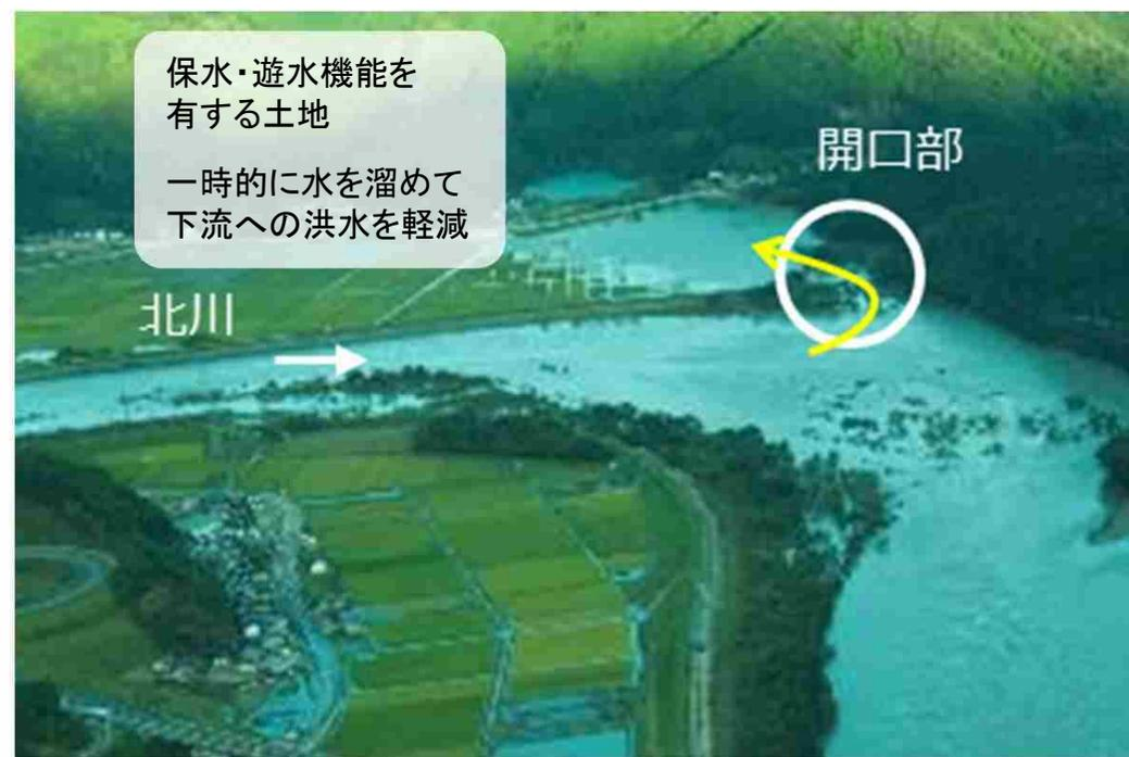
※霞堤: 堤防のある区間に開口部を設け、上流側の堤防と下流側の堤防が二重になるようにした不連続な堤防。洪水時には開口部から水が逆流して背後に溜まり、下流に流れる洪水の流量を減少させ、洪水が終わると、溜まった水を排水します。
