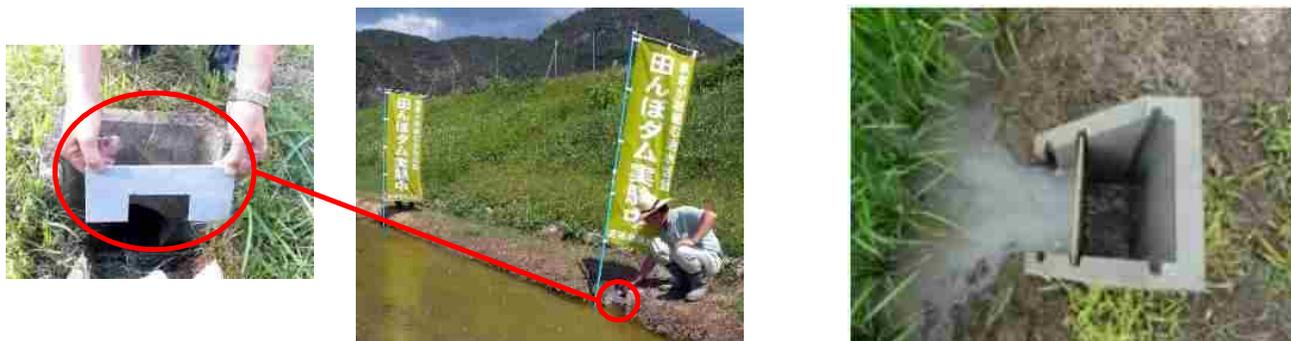
水田の排水口に流出量を抑制するための落水量調整装置を設置する等して、雨水貯留能力を人為的に高める
