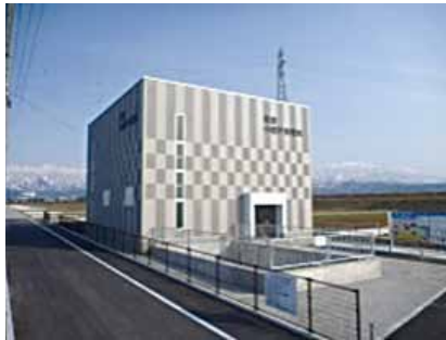
小水力発電所
