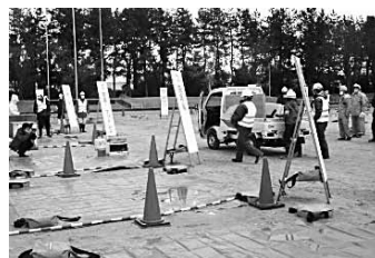
仮置場の設置・運営に係る訓練の様子
