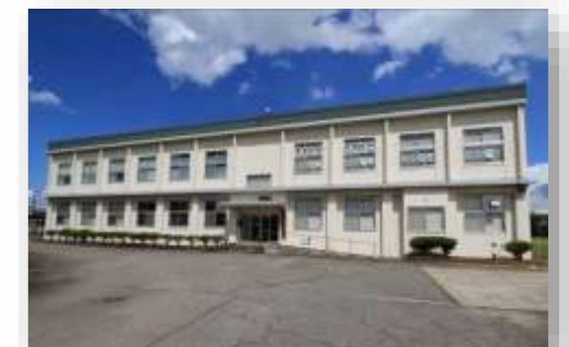
砺波センター (南砺市寺塚 301-1) 昭和 36 年 9 月 ~ (築 59 年)
