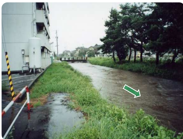
【平成10年7月出水状況】
