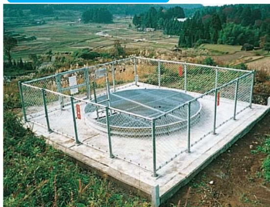
・集水井工 ・横ボーリング工 等
