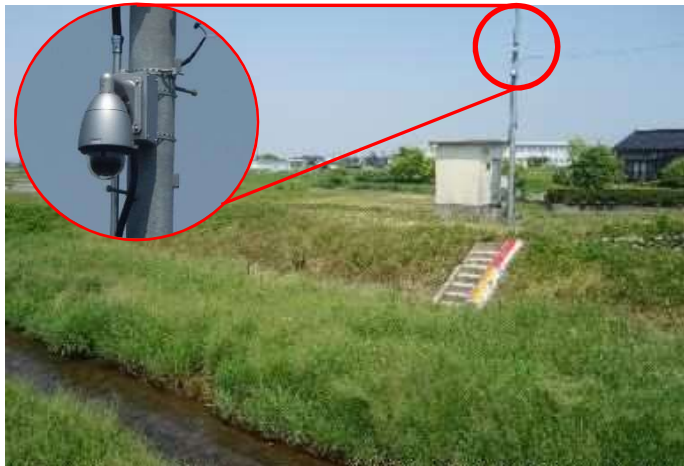
河川監視カメラ設置状況
