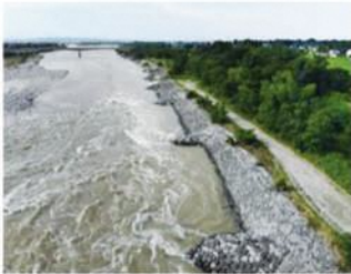
整備された神通川の護岸 ▲平成30年7月豪雨の時の様子 (出典：国土交通省北陸地方整備局)
