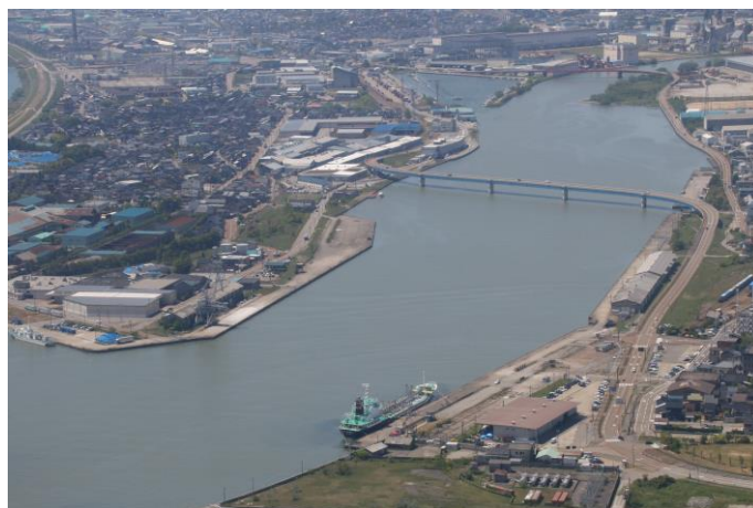
伏木万葉大橋
