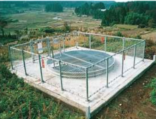
・集水井工 ・横ボーリング工 等
