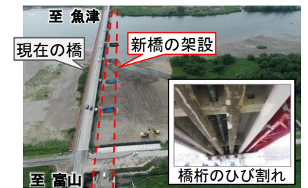
県道富山魚津線 今川橋の架替
