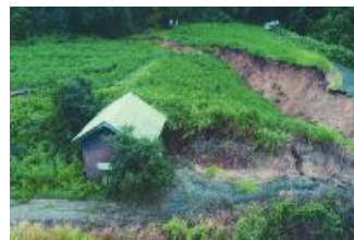
岩瀬 地すべり対策(R3.8災害発生)
