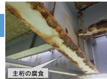
橋梁の老朽化対策 (県道新湊庄川線 雄神橋の損傷状況)
