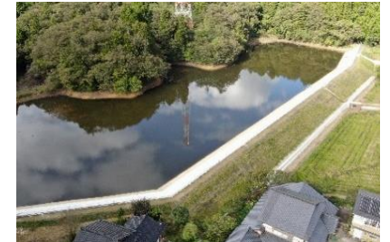
ため池の整備例(R3 新保大池地区)
