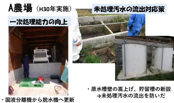
図 3 A 農場での改善対策事例
