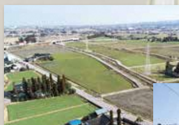
◀県営田添地区 (ほ場整備)
