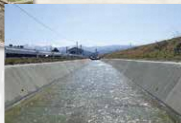
常東合口幹線水路▶
