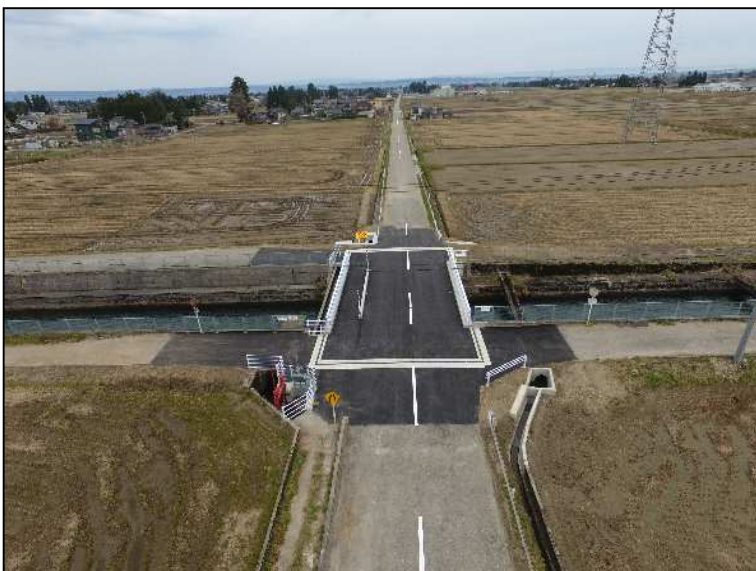
高尾建設・常南工業馬瀬口橋 1号架替工事共同企業体 馬瀬口橋 1号架替工事 発注者 富山市
