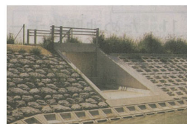
洪水吐き周辺の状態確認
