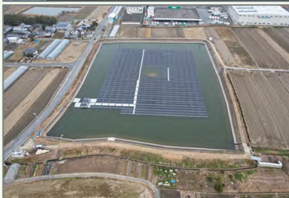
▲水上太陽光発電設備の設置状況
