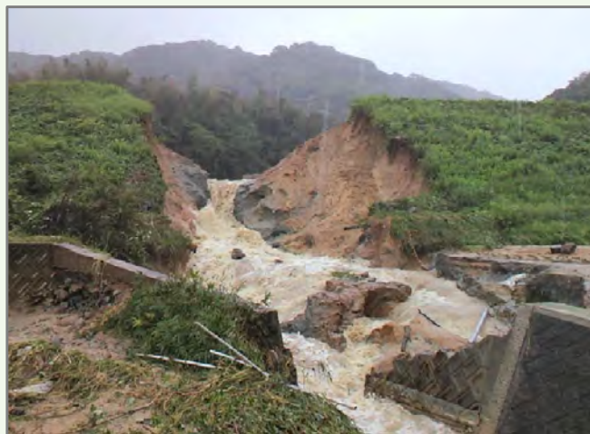
▲ため池（淡路島）の決壊の様子（平成23年9月）
