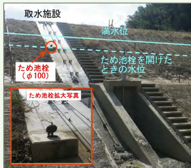
▲ため池栓の整備状況
