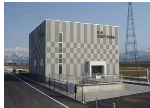
小摺戸発電所（入善町）
