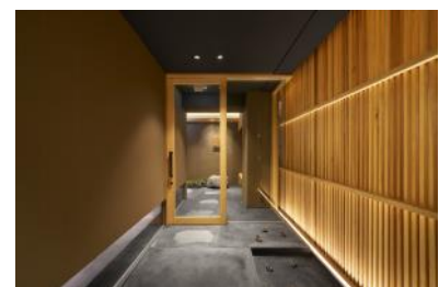
上／木格子は開閉可能な構造で昼の姿と夜の姿の2面性を創り出している 中／木格子を開いた様子 下／正面ののれんをくぐると木格子の裏面が間接照明に照らされ、食への期待感をいざなう
