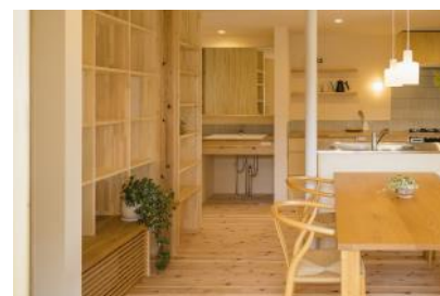
上／リビングダイニング。天井羽目板県産スギを使用 中／下見板張りは実加工のない板を千鳥で張り上げ 下／左下格子内の床下エアコン暖房により、床暖房の ような15mm厚の県産スギフローリングを実現
