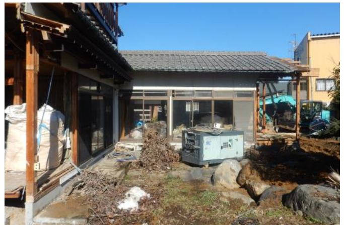
前ページ上部の写真と同一アングルの減築解体時の様子。この後、構造スケルトンの状態から耐震改修を行っている。
