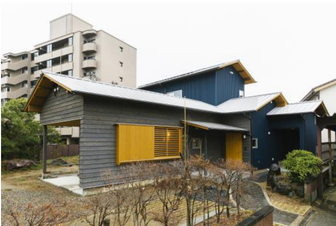
外見は減築前の形を残しつつ、耐震上の観点より瓦から葺き替えたガルバリウム鋼板葺きの屋根と、県産スギの下見板張りによって平屋部分の水平ラインが際立つデザインに。
