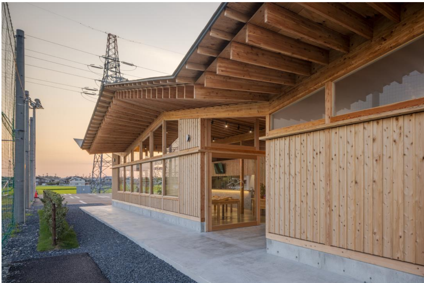
深めの軒が県産スギの外壁を守るとともに、軒下に屋外での飲食スペースを作っている。
