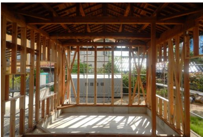
解体後、土間コンクリートの打設、基礎の新設、土台の交換、柱の新設・交換等が終了した際に室内より東面を見る。間柱、窓台・窓まぐさは県産スギを使用。
