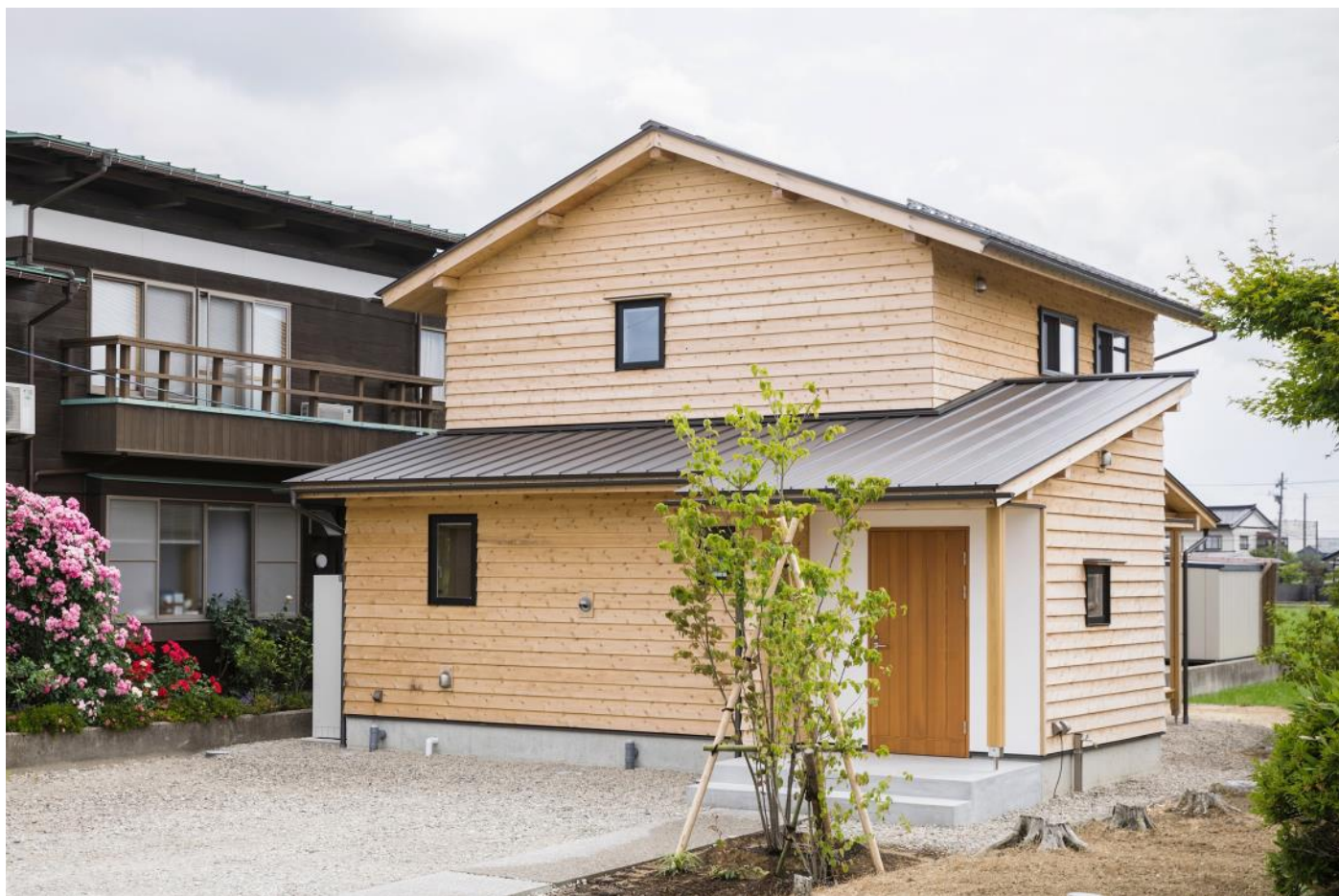
白漆喰で仕上げた玄関廻りを除く外壁全面が、無塗装の県産スギの下見板張りとなっている。経年変化による味わいも楽しみの1つ。
