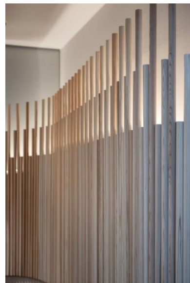
上／入口から見た内観 下／φ30のシリンダー状に加工された県産スギと 間接照明が来客を包み込む
