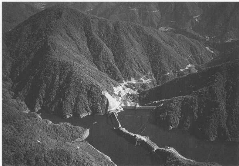
平成5年に完成した境川ダム（白山国立公園）
