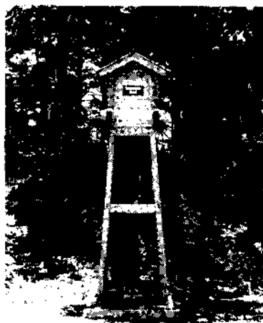
地下水位観測井
