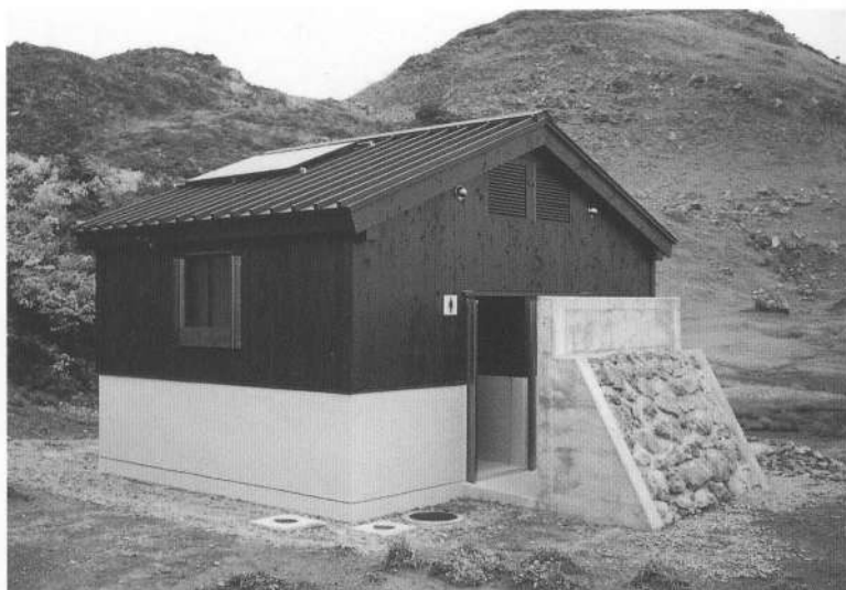
山のグッドトイレに選ばれた朝日平公衆トイレ (朝日町：朝日平野営場)
