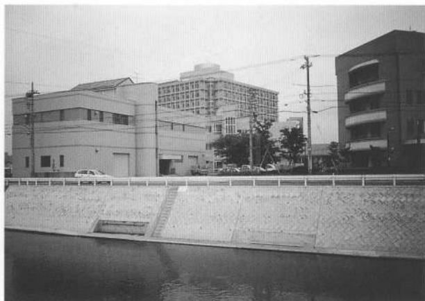
(河川水の取・放水設備)
