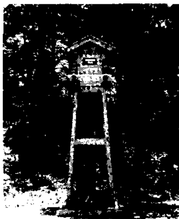
地下水位観測井
