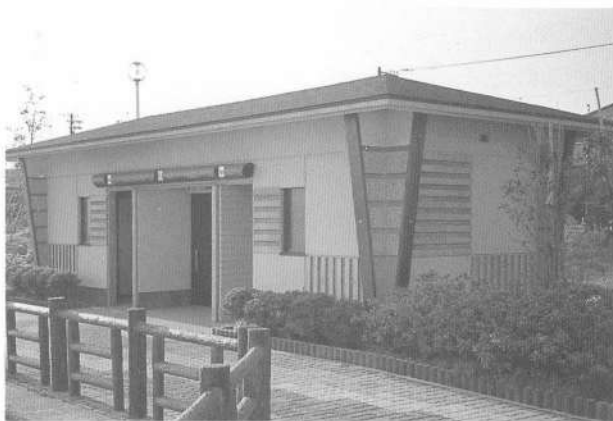
如意の渡し緑地公衆トイレ(高岡市伏木)
