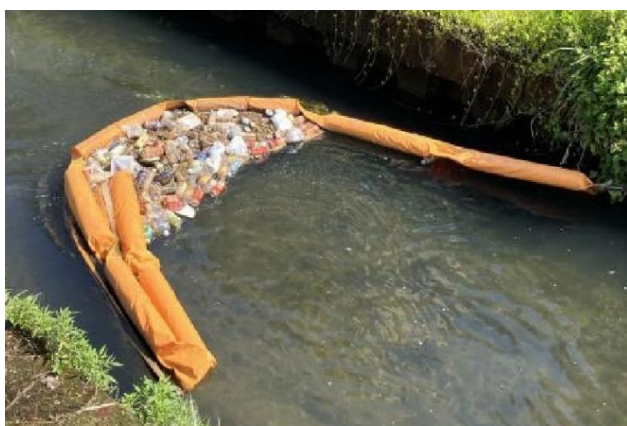
オイルフェンスの設置（富山市）
