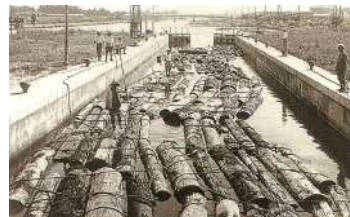
富山県富山港湾事務所 中島閘門パンフレットより
