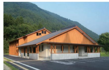
ホールの構造には流通材を接着して大スパンを実現する接着重ね梁を採用。外装材は軒を深くすることで雨がかりを防ぐ劣化対策が採られている。内装や雁木の使い方など、木材活用の要所を堅実に抑えた造りが評価され、優秀賞に選ばれた。
