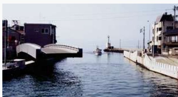
▲黒部漁港生地中橋（片持ち式旋回橋）
