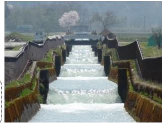
落差を有する農業用水路 (滑川市杉本地内)
