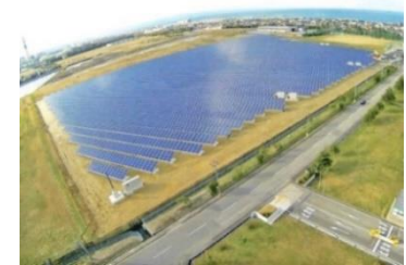
富山新港太陽光発電所 (県企業局)
