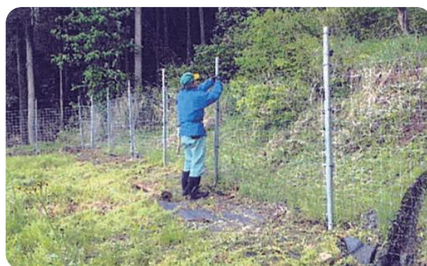
電気柵周辺の点検・修理
