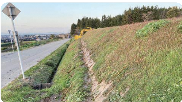
法面に作業足場制作
