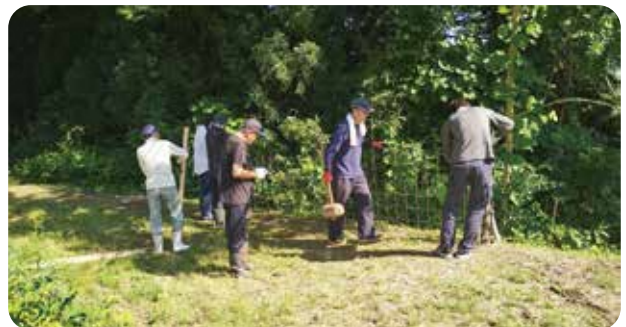
耐雪型恒久柵の設置
