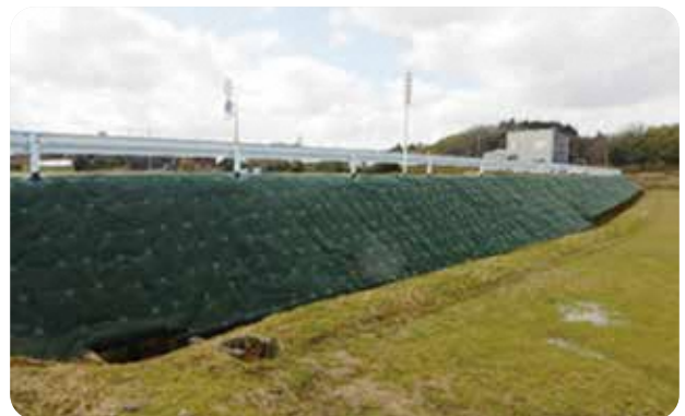
急傾斜農地での防草シート設置
