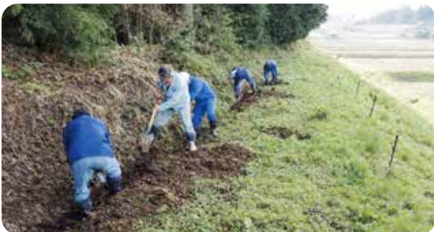
水路の維持管理
