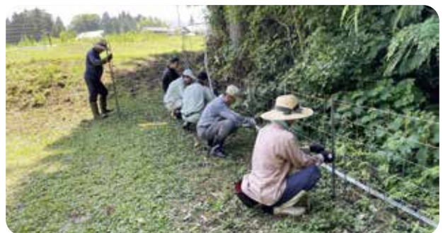
ワイヤーメッシュ柵設置
