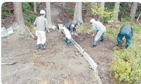
協定者による水路補修
