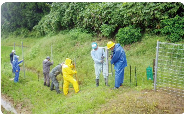
耐雪型侵入防止柵の設置
