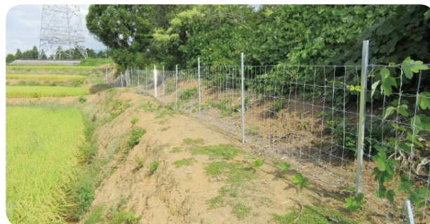
耐雪型侵入防止柵設置箇所
