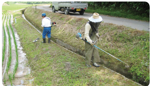
水路法面の草刈り
