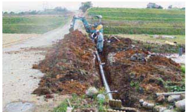
暗渠排水の施工
