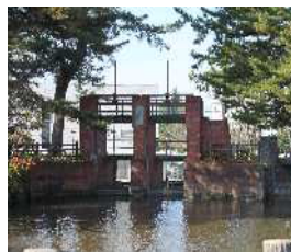
新庄排砂水門
