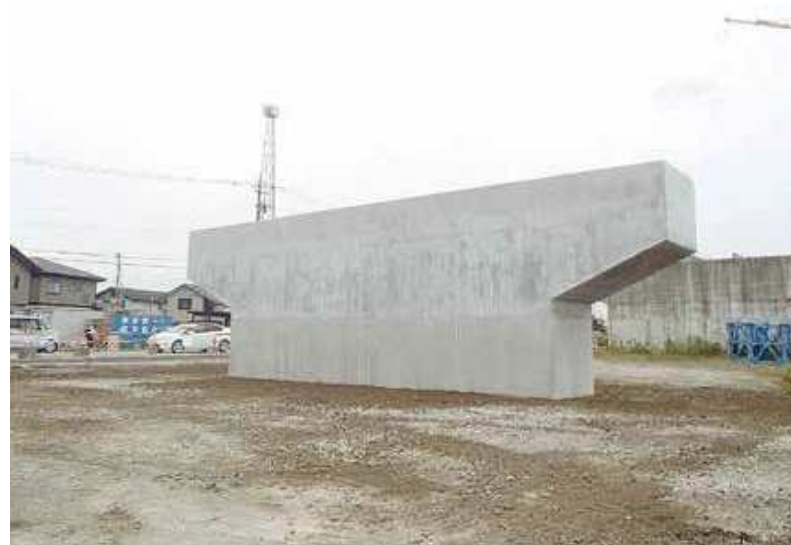
五本建設(株)施工の「一般国道 415 号道路総合交付金東富山跨線橋下部工 (P8 橋脚) 工事」
