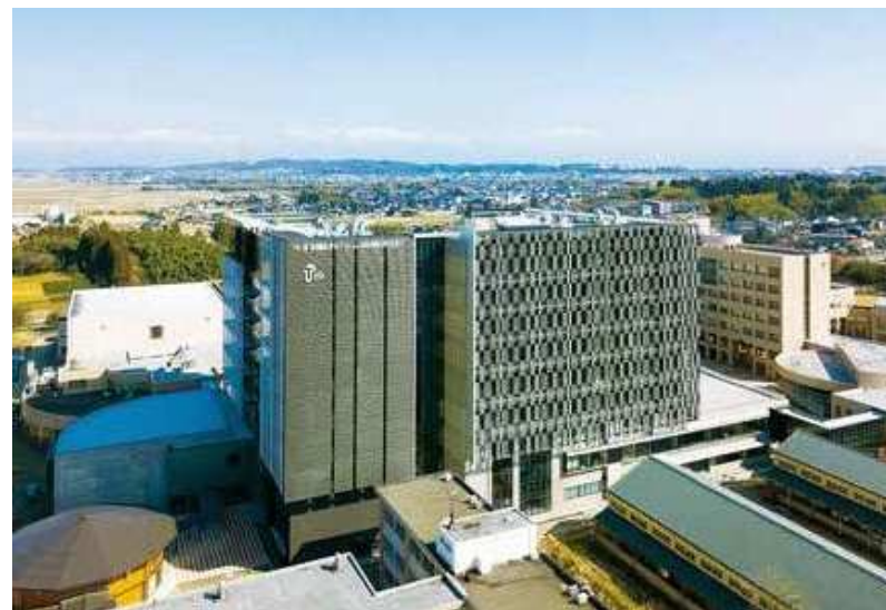
佐藤工業・塩谷建設・射水建設興業富山県立大学新棟新築工事 共同企業体施工の「富山県立大学新棟新築工事」
