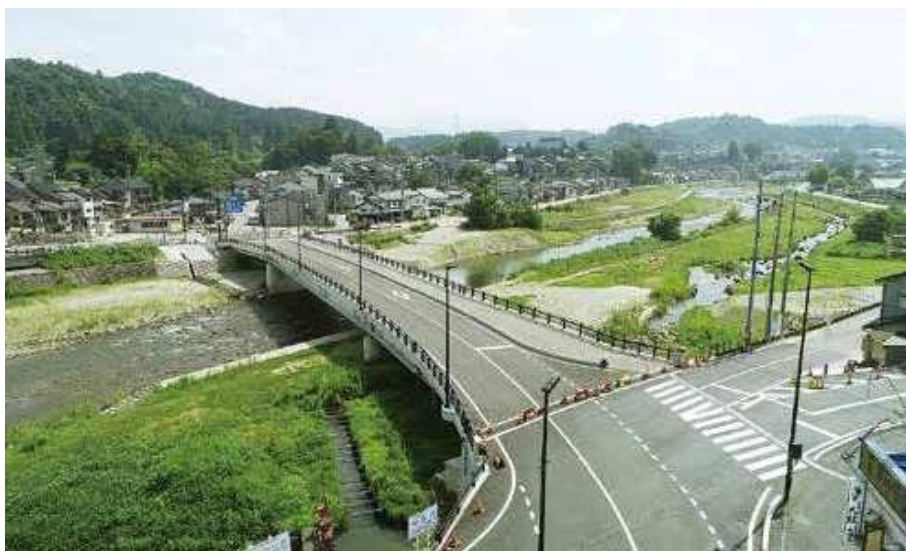
川田建設(株)北陸支店施工の「一般国道 472 号道路総合交付金十三石橋上部工事」
