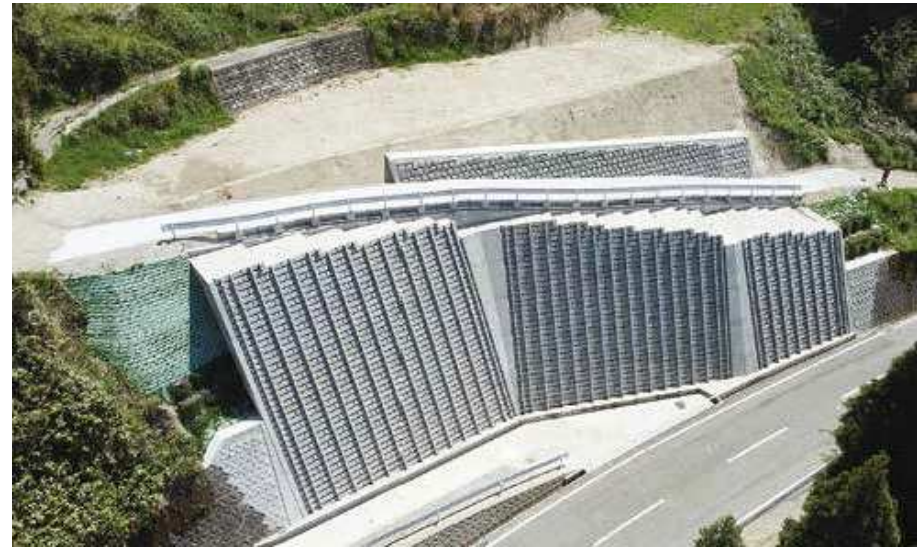
(株)干場建設施工の「主要地方道高岡羽咋線道路災害復旧擁壁工工事」
