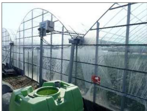
防犯カメラの設置
