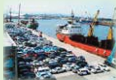
富山地区1~3号岸壁
