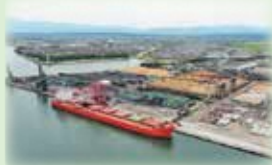
水深14m 連続560m 岸壁(中央ふ頭)
