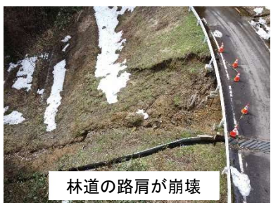
法面が崩壊し水路が閉塞
