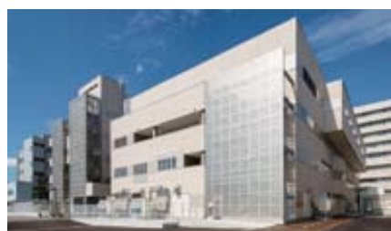
県立中央病院先端医療棟
