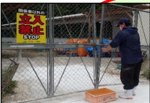
フェンス設置
