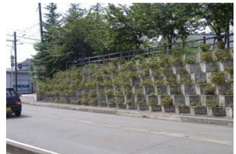
擁壁に低木が植栽可能な構造とし、擁壁の圧迫感を軽減し、うるおいを創出している。(射水市)
