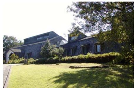
鉄筋コンクリートの躯体にウッドシングルを葺いて自然景観に調和させている。(富山市)
