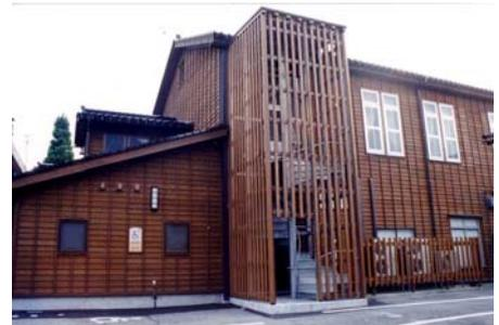
金属製の外階段を木の格子で覆い、木造建築との調和を図っている。(南砺市)
