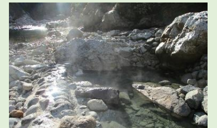
河原露天風呂の補修(R2.11実施)
