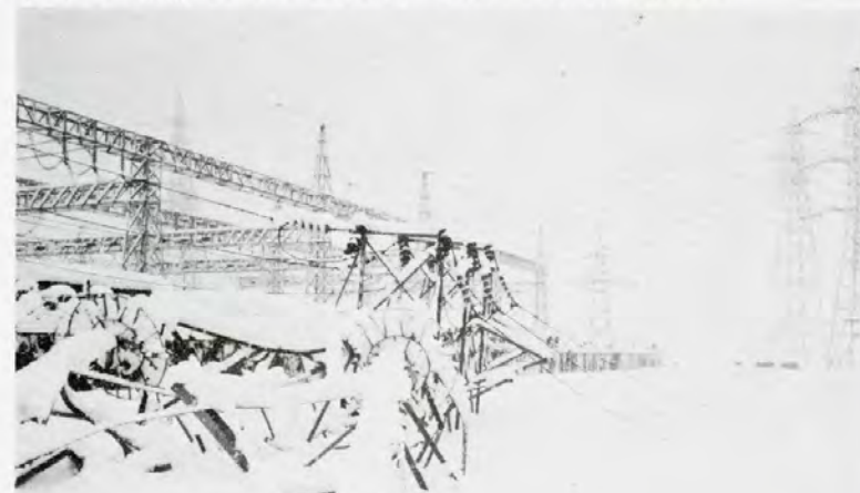
電力県富山の象徴ともいべき高压鉄塔は 雪けむりを上げながら崩れ落ちた
