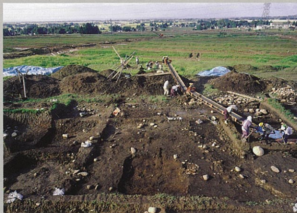
B地点作業風景（南から）
