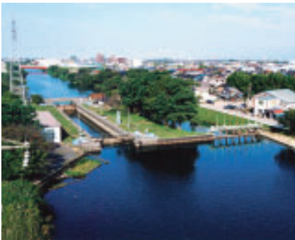
富岩運河、中島閘門
