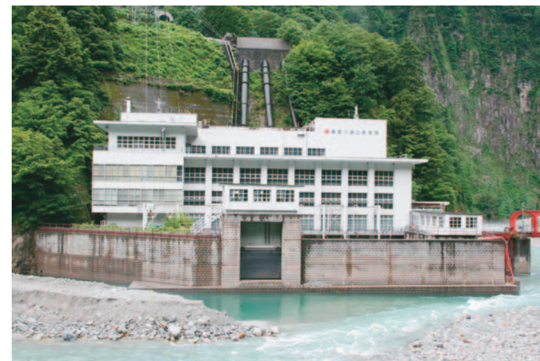
黒部川第二発電所
