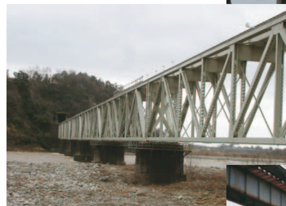
第一神通川橋梁
