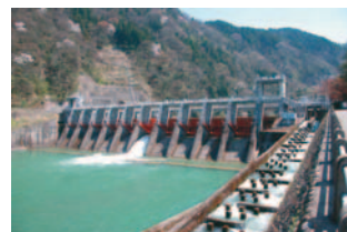
庄川用水合口堰堤
