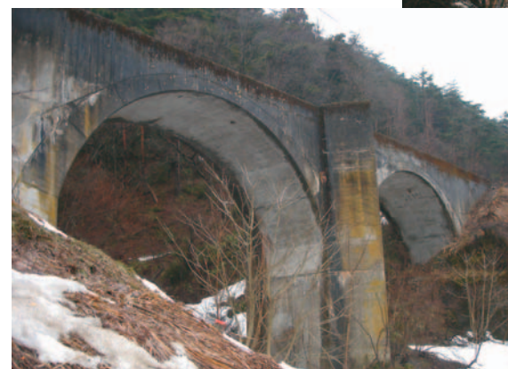
第二砂場橋梁
