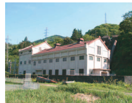
松ノ木発電所
