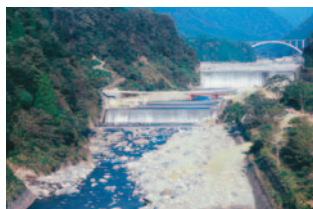
本宮砂防堰堤
