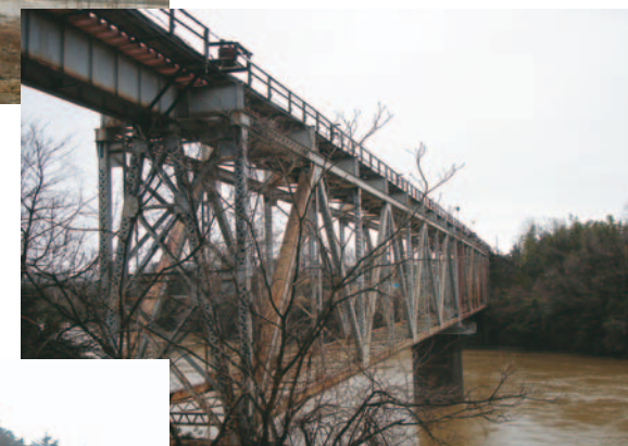
第二神通川橋梁
