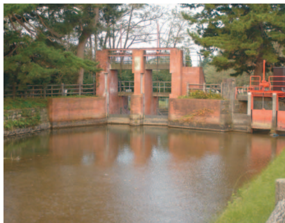
新庄排砂水門
