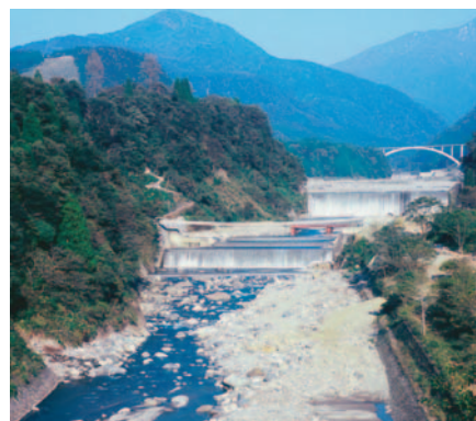
本宮砂防堰堤
