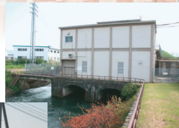
五平定発電所
