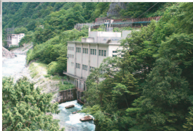
黒部川第三発電所
