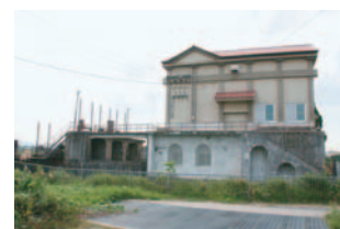
下井沢発電所
