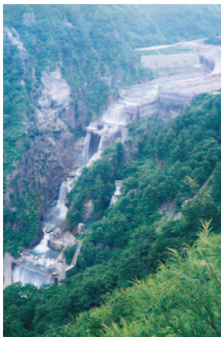
白岩砂防堰堤
