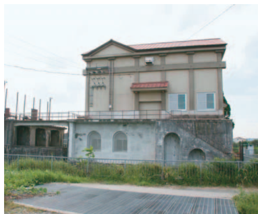
下井沢発電所
