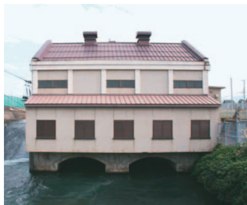
四津屋発電所
