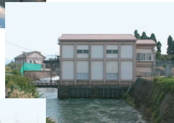
成子第一発電所
