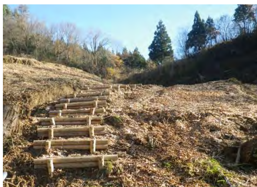
歩道や丸太階段の施工 （黒部市田粍）
